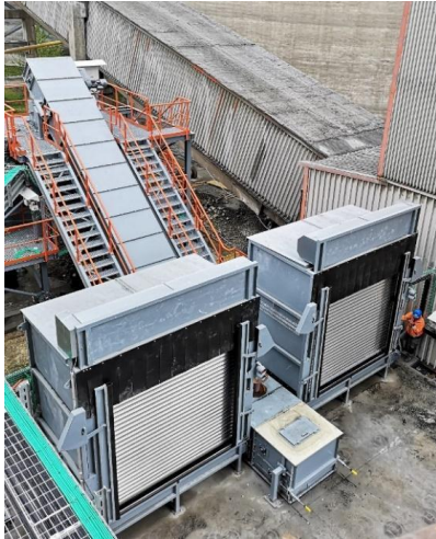
Bild 3: BG OptiDock ist eine Lkw-Anlieferungsstation für alternative Brennstoffe (Quelle: BEUMER Group)
