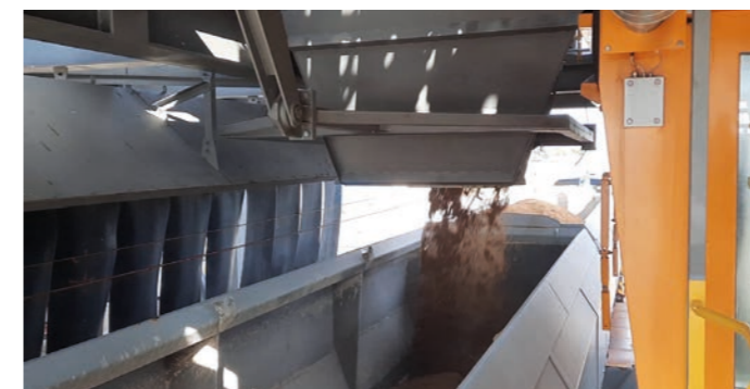
Zugbeladung, Braunkohle 400 - 7500 t/h, Deutschland
