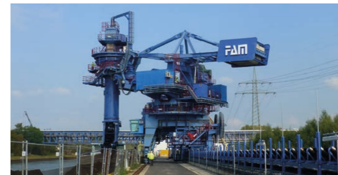
Conti-Schiffsentlader CSU1100.14S, verfahrbar, Entladung mit Becherwerk, Kohle 1100 t/h, Deutschland
