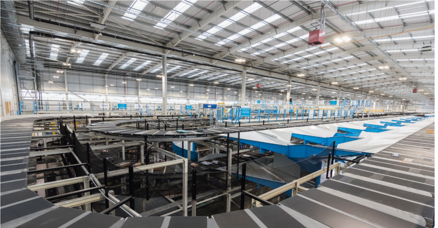
Hochleistungssortieranlage mit minimiertem Verschleiß und Wartungsaufwand
